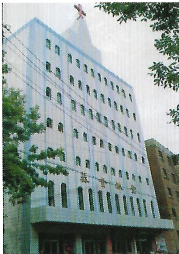
图 10: 明德路堂的新堂全景
